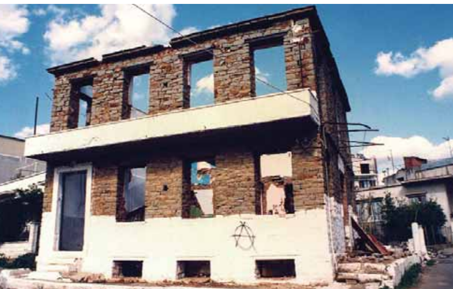
Σταδιακή χειρωνακτική αποξήλωση διώροφου σπιτιού στην γωνία Παναγοπούλου και Χρυσανθού Αιτωλού 9, σε μια εποχή που ακόμη γινόταν ανακύκλωση οικοδομικών υλικών.
