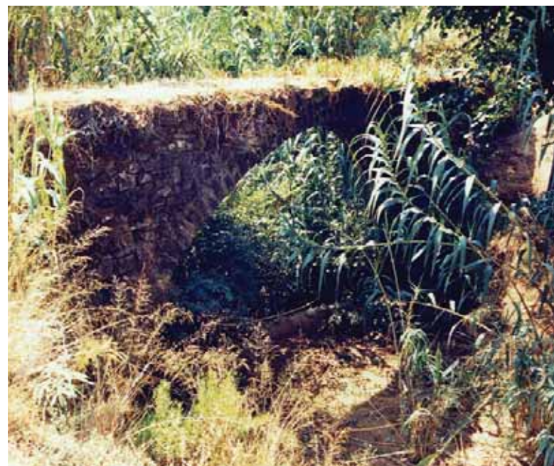
Νερογέφυρο που η στέψη του ήταν διαμορφωμένη σε υδραύλακα για κάποιο μύλο στην περιοχή Συκούλα.
