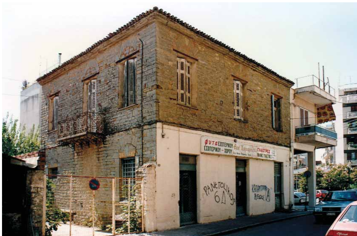
Διώροφο σπίτι, οδός Μακρή 2.
