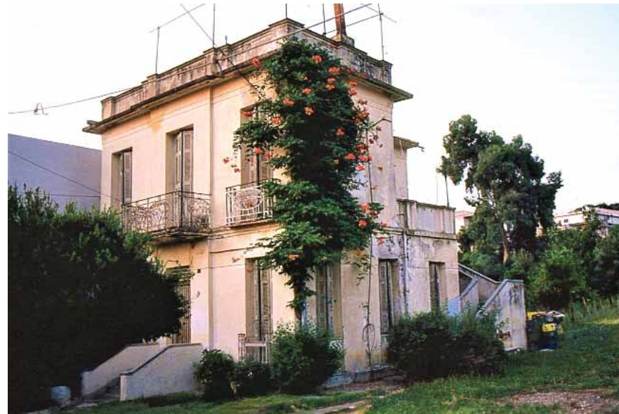
Δώροφο σπίτι με ανοιχτή βεράντα στο πίσω μέρος. Ιδιοκτησία Κοντούλη, οδός Σαμώτη 22-24.
