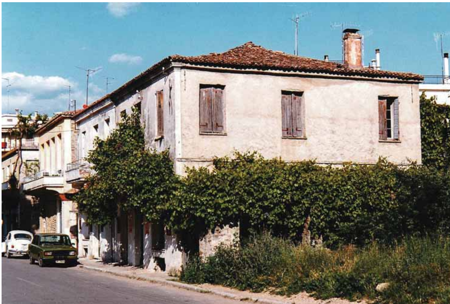
Τυπικά δώροφα σπίτια με κατοικίες στο ισόγειο και τον α' όροφο. Οδός Αγίου Χριστοφόρου 24-26-28-30.
