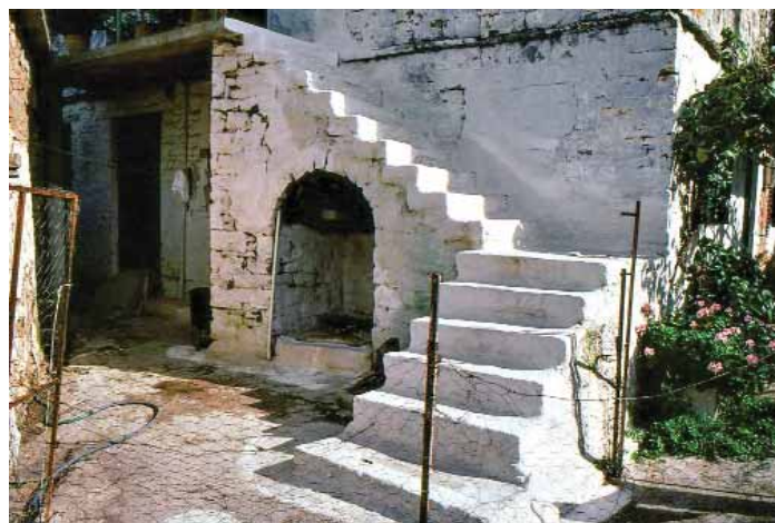
Κλίμακα τύπου γάμμα με τοξωτή κόγχη στην οδό Χένδερσον.
